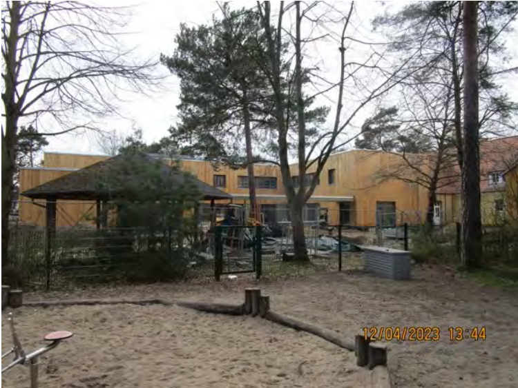
Anbau Grundschule Lehnitz
