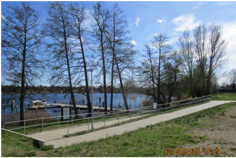
Errichtung Steganlage am Lehnitzsee
