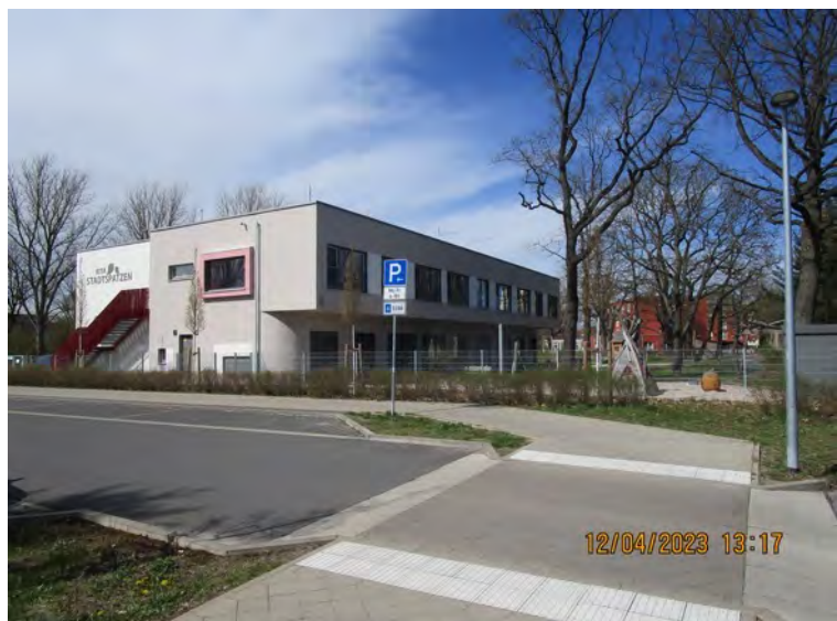
Neubau Kita Speyerer Straße
