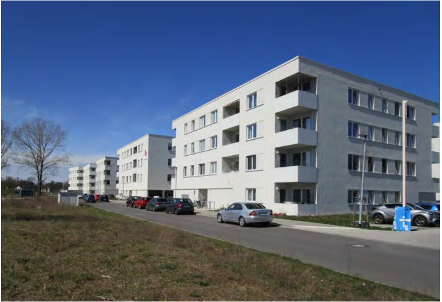
Wohnbauvorhaben Weiße Stadt
