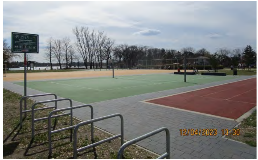
Neubau Freizeitanlage Mainzer Straße
