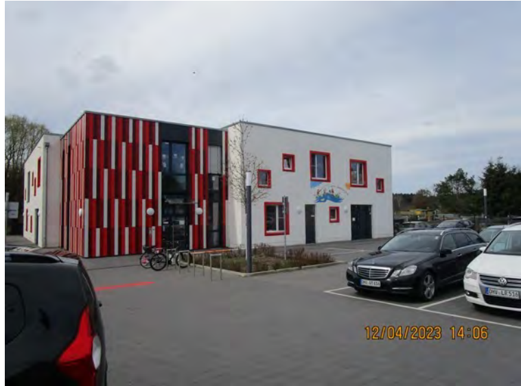
Neubau Kita Schmachtenhagen
